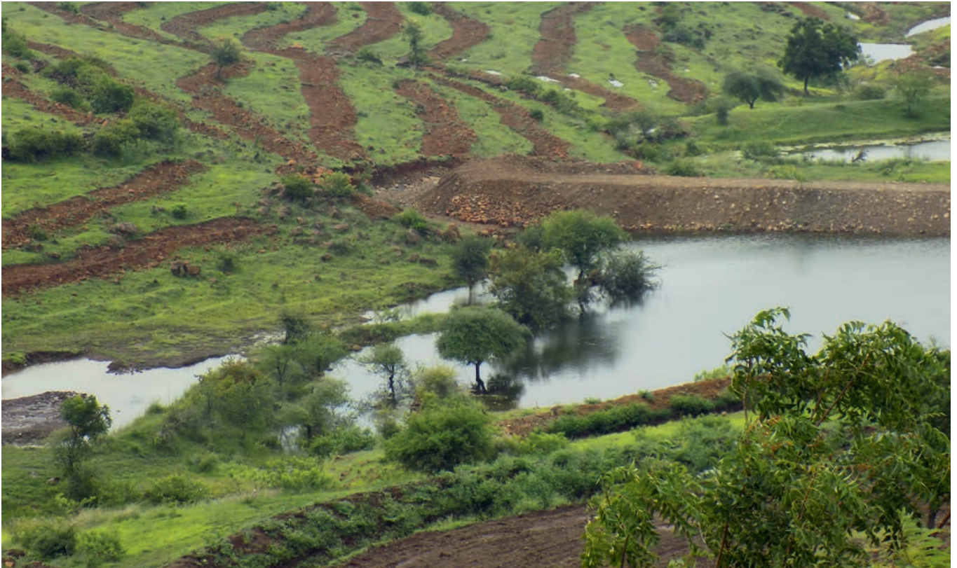
Hier bremsen Konturgräben (oben) entlang der Topografie des Geländes das Regenwasser und verhindern, dass es zu schnell versickert. So dringt die Feuchtigkeit auch in tiefere Bodenschichten ein. In Mulden bzw. «Absorptionströgen» lässt sich das Wasser auffangen.
