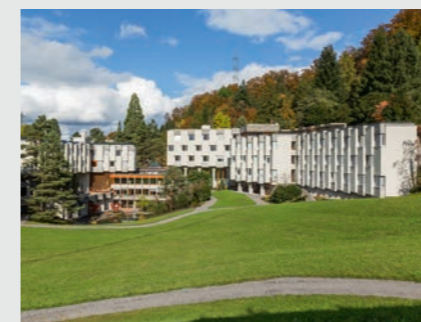
Lassalle-Haus Bad Schönbrunn
