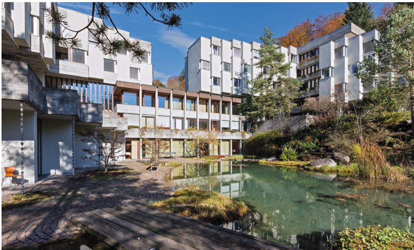
Ein Grossprojekt: Nach der umfangreichen Renovation ist das Lassalle-Haus Bad Schönbrunn für die Zukunft gut gerüstet.
