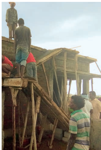
LINKS: Monsun und Wirbelstürme zum Trotz: Die Janadi bauen eine neue Häuserzeile in Garuvupalem, Andhra Pradesh.
