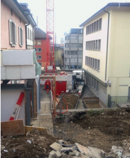
Blick über den schmalen Hof Richtung Urania: Der Kranaufbau war Massarbeit.
