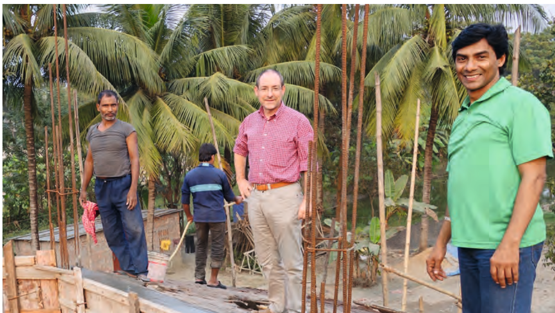
Auf der Baustelle: Provinzial Christian Rutishauser SJ (Mitte) mit Pater Saju SJ (re.) auf dem Dach der künftigen Kirche des Kunst- und Kulturzentrums Kalahrdya in der Nähe von Kalkutta.
